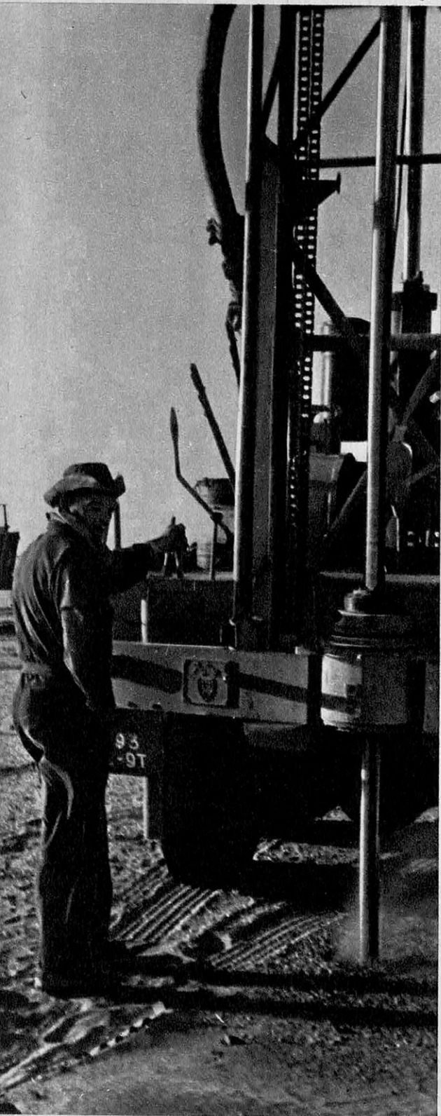
UNE FOREUSE LÉGÈRE en action. Montée sur camion, cette machine qu'emploient les équipes sismiques utilise un foret rotatif avec de l'air comprimé.
