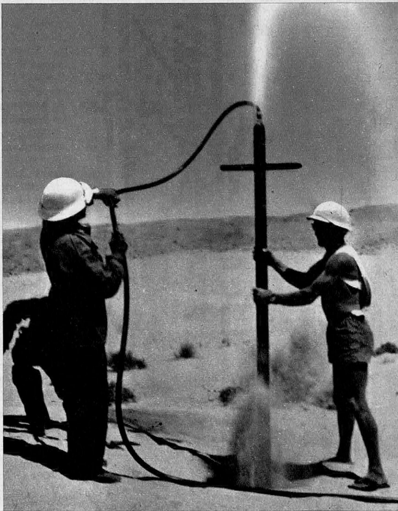
Le forage à l'air comprimé dans une dune
