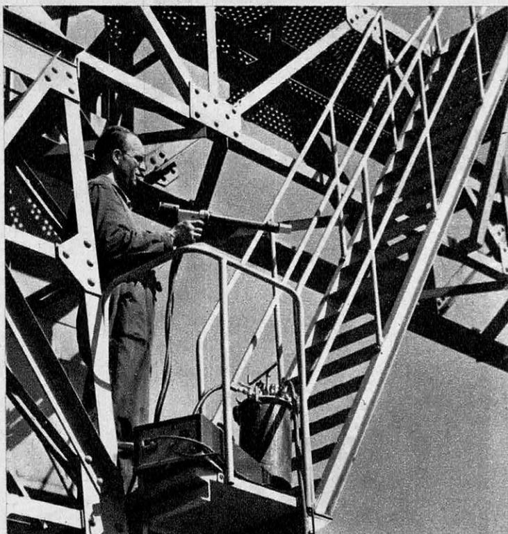
JUSQU'À présent, la peinture électrostatique n'était utilisée que dans des installations fixes, pour des chaînes de fabrication de grande série pouvant amortir le coût relativement élevé de l'installation. Les avantages du procédé
