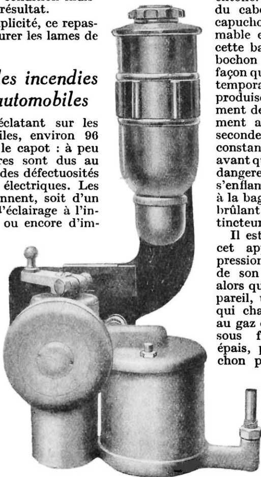
CARBURATEUR ÉQUIPÉ AVEC UN « ASSURO » (EN HAUT) CONTRE LES DANGERS D'INCENDIE
