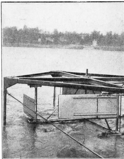
LA TURBINE A MOITIÉ IMMERGÉE DANS LA RANCE, EN FACE DE SAINT-SERVAN (C.-DU-N.)
