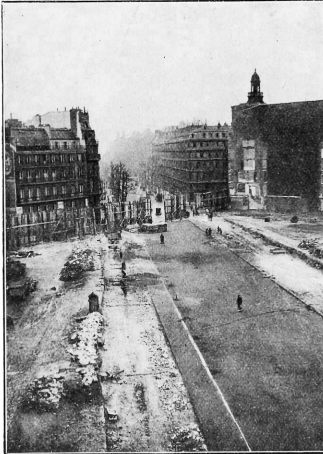
LE DERNIER TRONÇON DU BOULEVARD HAUSSMANN, PEU AVANT L'ACHÈVEMENT DES TRAVAUX
