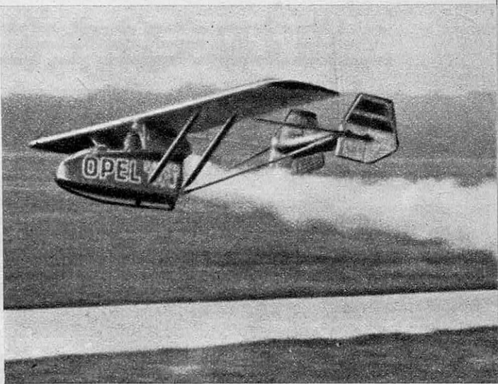
● Le 30 septembre 1929, en Allemagne, Opel pilotant le premier planeur à réaction parcourut 1 500 m. L'appareil était propulsé par un ensemble de six fusées à poudre.
