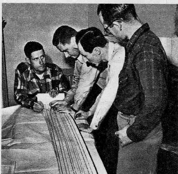
● Sur cette bande de papier s'inscrivent automatiquement les résultats des mesures effectuées par les instruments de la fusée, transmis au sol par radio.
