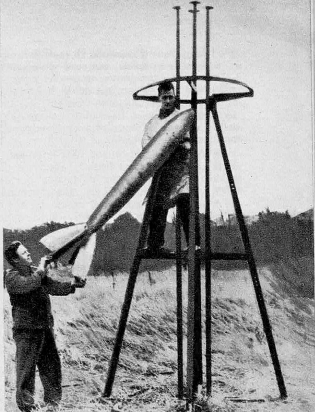
● En 1930 et 1931, Oberth, Riedel et Nebel mirent au point une fusée qui présentait déjà tous les caractères d'une V-2. Longue de 2,18 m et d'un diamètre de 35 cm, elle aurait théoriquement dû s'élever à 20 km d'altitude. Dans la réalité, elle ne dépassa pas 100 m.
