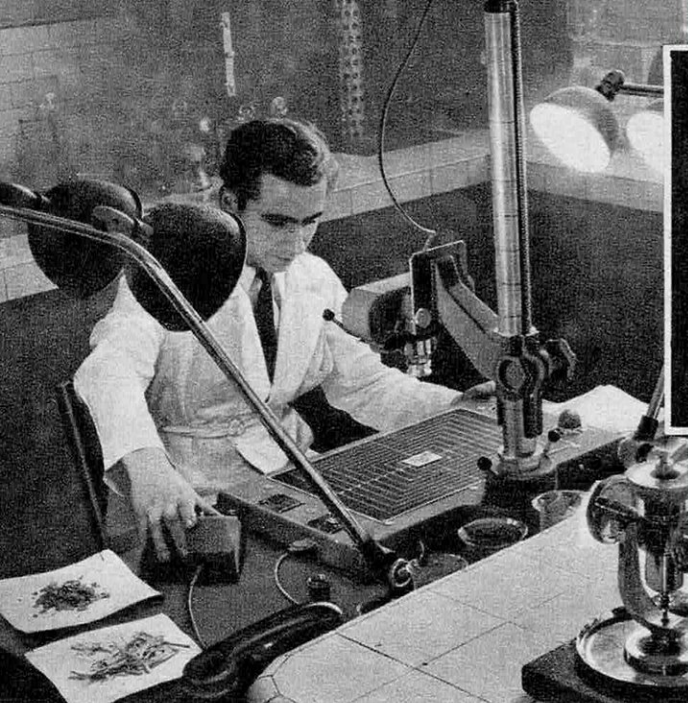
● Cette caméra reçoit des carters interchangeables avec 10 m. de film. La table qui porte les documents permet, grâce à une série de cadres rectangulaires d'évaluer rapidement la distance optimum de prise de vue. L'installation est ici utilisée, non pour reproduire un document, mais pour photographier des échantillons de produits dans un laboratoire. (Sté de construction d'appareils de précision Microfrance).
