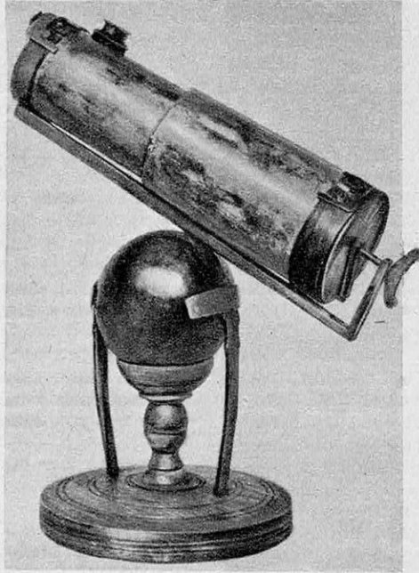
NEWTON tailla de ses mains le miroir du premier télescope dont la réplique exacte est conservée au Science Museum de Londres.
