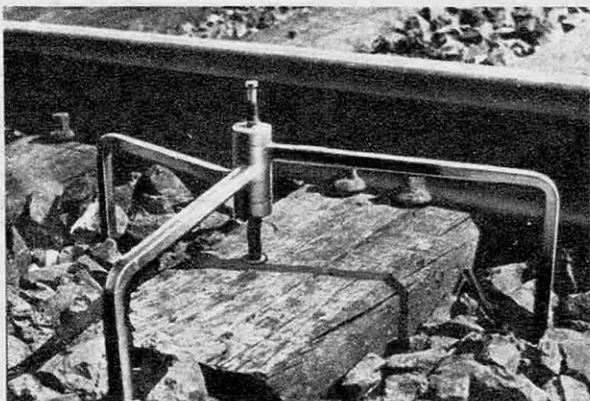
● La hauteur dont une traverse « danseuse » s'enfonce sous le poids d'un train est mesurée à l'aide d'un « dansomètre » qui détermine la quantité de gravier à « souffler ».
