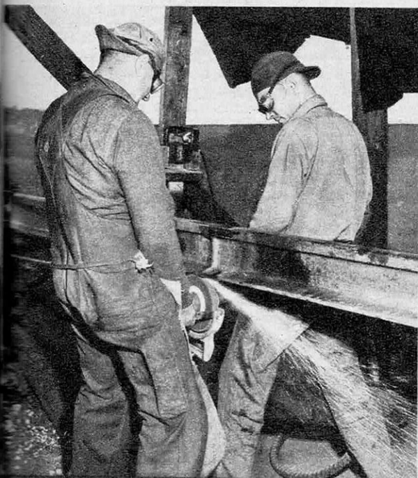
3 Les rails soudés électriquement sont meulés et offrent des surfaces de roulement sans aspérités.
