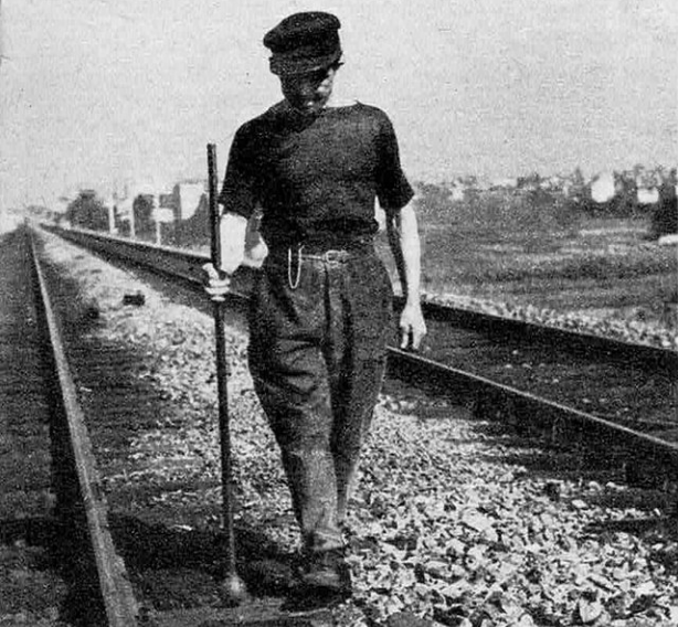
● Pour repérer les traverses « danseuses », on laisse tomber sur chaque traverse une « canne à boule » et on écoute le son, creux ou plein, produit par le choc.
