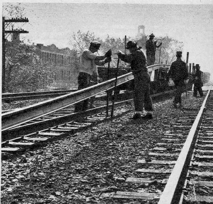
4 Ces rails de 200 m de long, flexibles comme des rubans, sont transportés en wagons et posés sur la voie.
