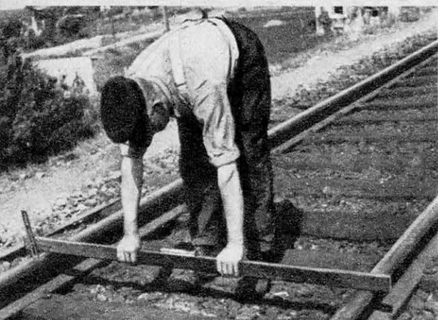
● La différence de niveau entre les deux files de rails est mesurée au moyen d'une règle et d'un niveau gradué que l'on dispose transversalement sur la voie.
