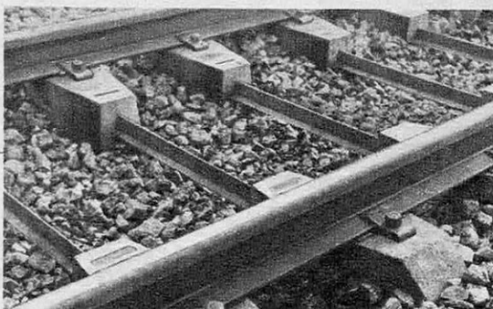
● Fixation du rail par crapauds « R. N. » sur traverses mixtes « R. S. ». Les traverses étant conductrices, on doit interposer une plaque isolante entre rail et crapaud pour pouvoir utiliser la signalisation par circuits de voie.
