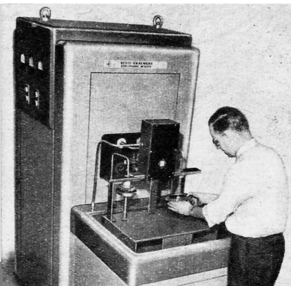
Générateur à induction de 20 kW pour traitement superficiel des pignons (Allis Chalmers).
