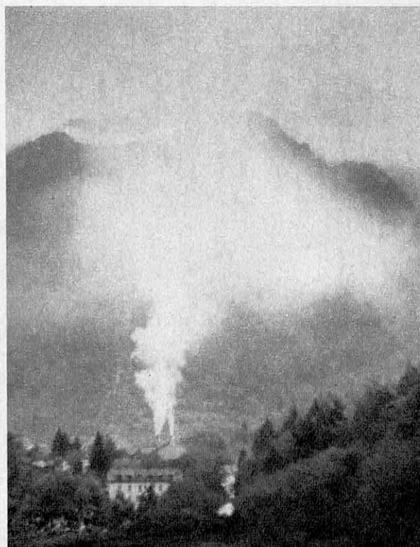
Installées dans les vallées montagnardes, les vieilles usines de production d'aluminium libèrent des composés du fluor provenant des bains d'électrolyse. Ils provoquent de notables dégâts.
