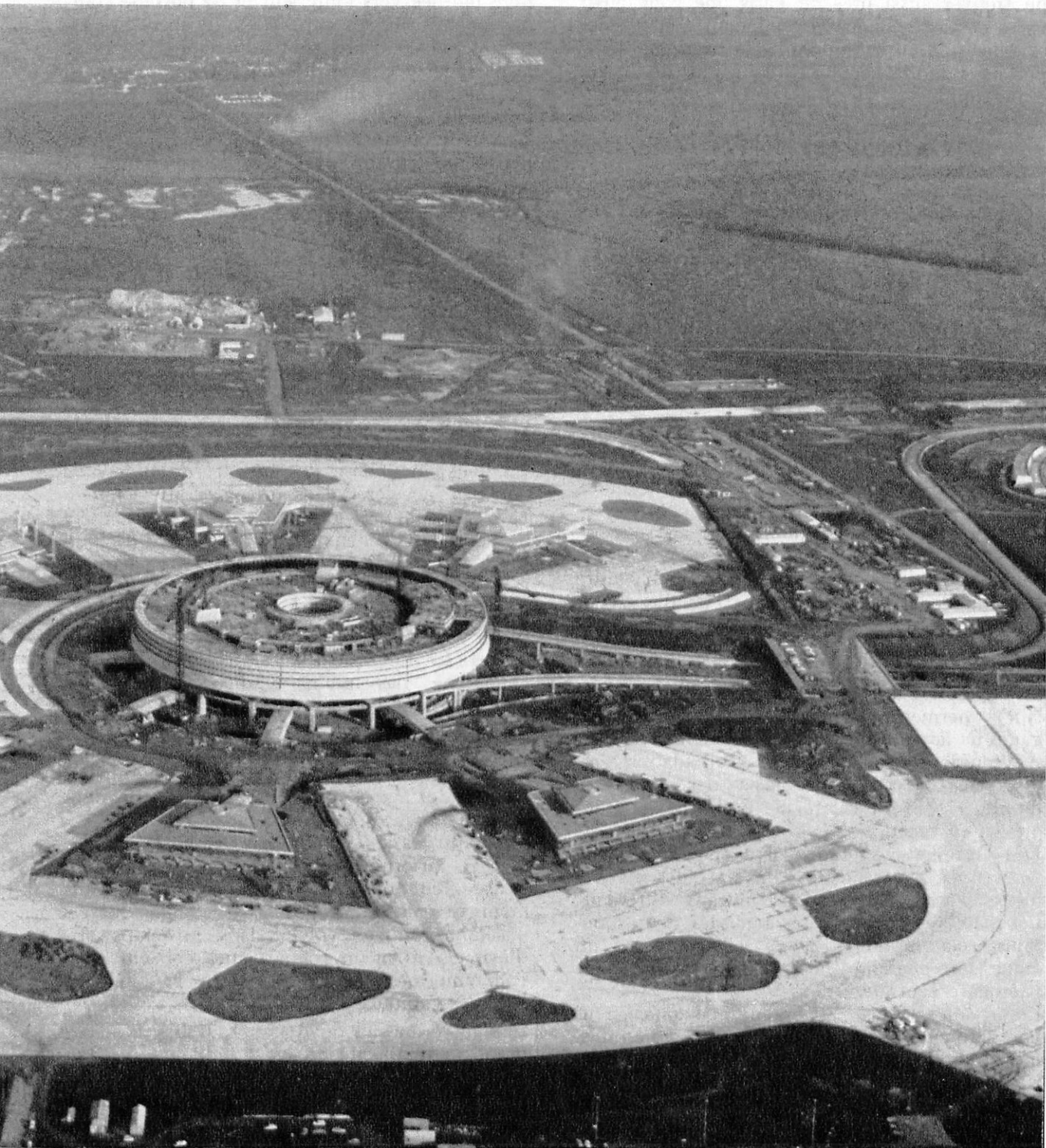
d'avions gros porteurs a conduit à la conception de Roissy 1 : aérogare centrale et sept bâtiments satellites.
