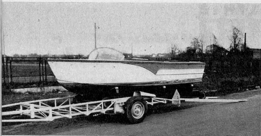
remorque U.F.A.C., avec chariot de mise à l'eau, remorque Bal'Hamac pour transport et mise à l'eau
