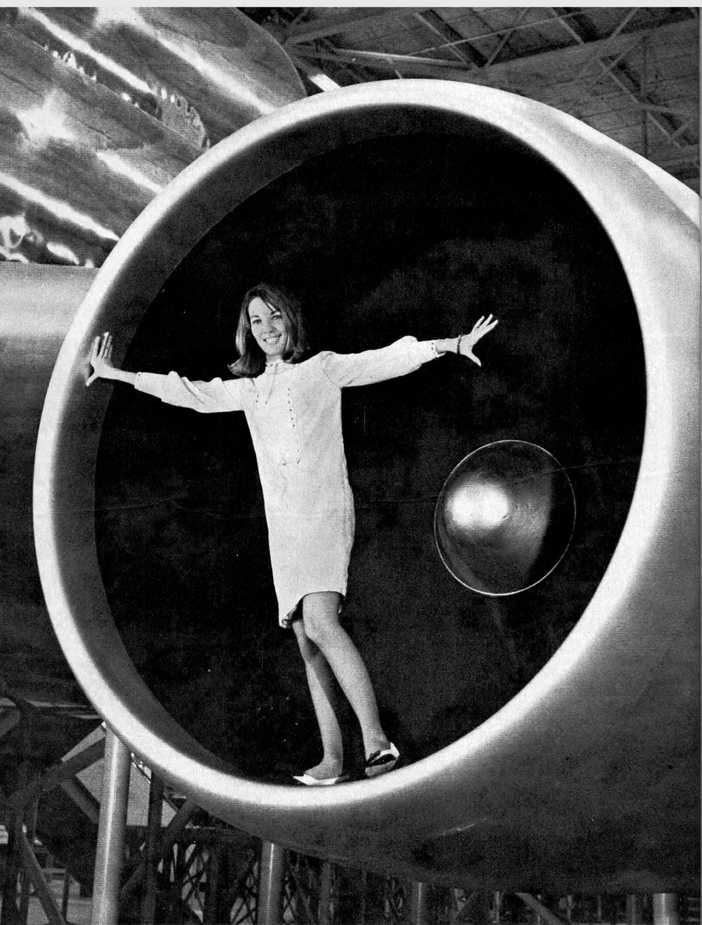
La prise d'air de 2,64 m de diamètre des réacteurs du 747, long-courrier pour 490 passagers.
