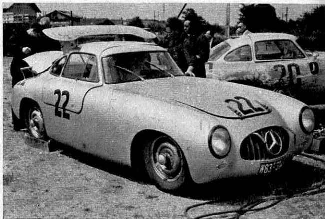
C'est en juin 1952 que Mercedes est revenu au Mans avec le coupé sport expérimental 300 SL dont une version ne tarda pas à être commercialisée. Déjà des essais de freins aérodynamiques, repris en 1955, furent poursuivis au Mans ; mais cette solution ne fut pas retenue en course. C'est avec une voiture de ce type que Lang et Riess allaient remporter les 24 Heures à la moyenne de 155,574 km/h. Le moteur 6-cylindres développait 175 ch. A droite, une vue du départ des 1 000 km du Nurburgring en mai 1955 : les trois barquettes Mercedes 300 SLR (moteur 8-cylindres en ligne à injection), celles de Fangio, de Moss et de Kling qui devaient terminer respectivement 1 er , 2 e et 4 e .
