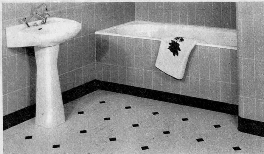
Les dalles de vinyle-amiante sont utilisées non seulement pour les sols, mais également pour le revêtement de certaines surfaces verticales.
