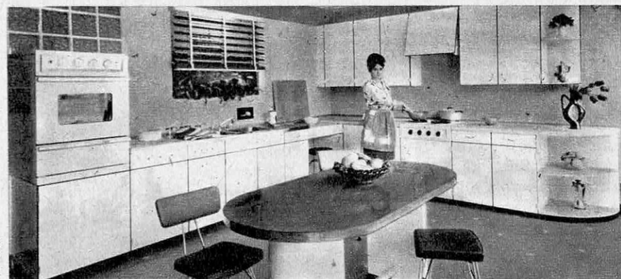
Un ensemble de cuisine en lamifié avec table centrale où la famille peut prendre ses repas ; la hotte d'évacuation placée au-dessus de la cuisinière s'intègre heureusement dans les éléments hauts de rangement.
