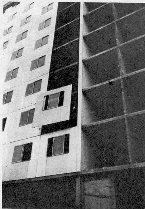
Des panneaux de façade légers avec âme isolante et parements en amiante-ciment,
