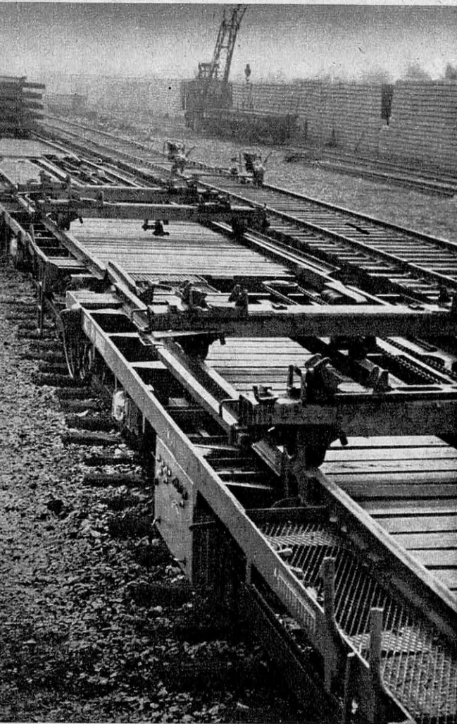
Dans un atelier type « Est », une rame spécialisée pour les substitutions de voies. Au second plan, le wagon porteur où les « colis » de panneaux de voie de 18 m sont entassés sur cinq épaisseurs. Ces éléments, posés sur des lorries, sont déplacés sur un chemin de roulement continu le long de la rame à l'aide d'un dispositif de touage par chaîne dont on peut voir le mécanisme sur le wagon « toueur » au premier plan.
