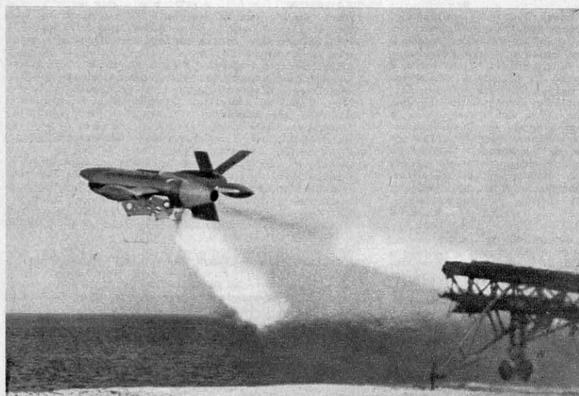
De l'engin-cible télécommandé par radio Nord CT-20 dérivent le R-20 de reconnaissance et le missile sol-mer ou mer-mer M-20, ci-contre, destiné à la Marine suédoise, portant à 250 km.
