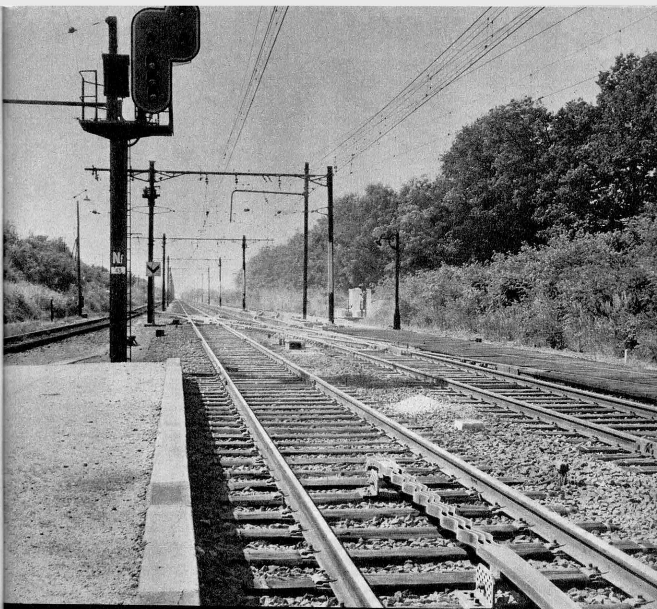
Pour la répétition des signaux sur les locomotives, ci-dessus le « crocodile » de voie, ci-dessous les balises de voie à gauche, et, à droite, les capteurs correspondants installés sous une locomotive.
