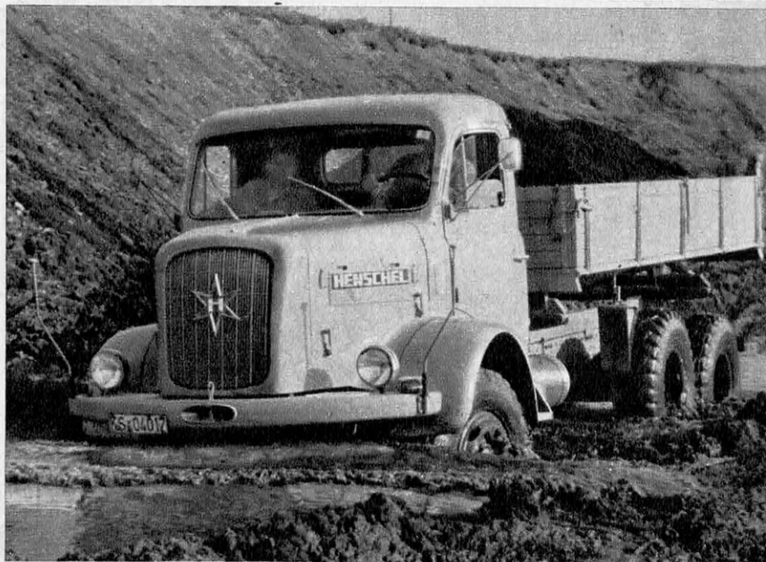
Benne basculante Henschel toutes roues motrices, type HS 12 HAKV 13,5 tonnes à cabine semi-avancée, avec moteur 140 ch ou 158 ch.
