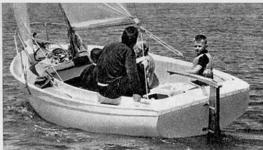
« Picoteux », quillard familial pour la promenade et la pêche, construit par Jouët. Très stable, il peut aussi être muni d'un hors-bord qui s'installe dans un puits. Le cockpit est spacieux et très bien défendu.
