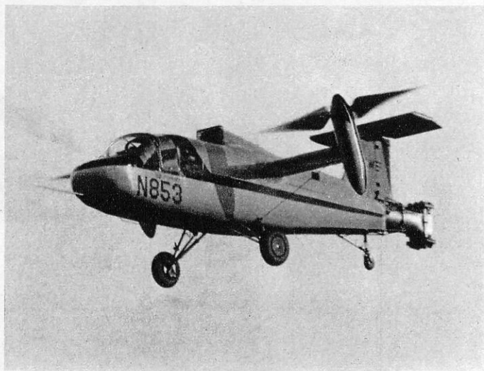
Précurseur du Model 200 de Curtiss-Wright (X-19), en haut à droite, le Model 100 qui a éprouvé la formule en vol.
