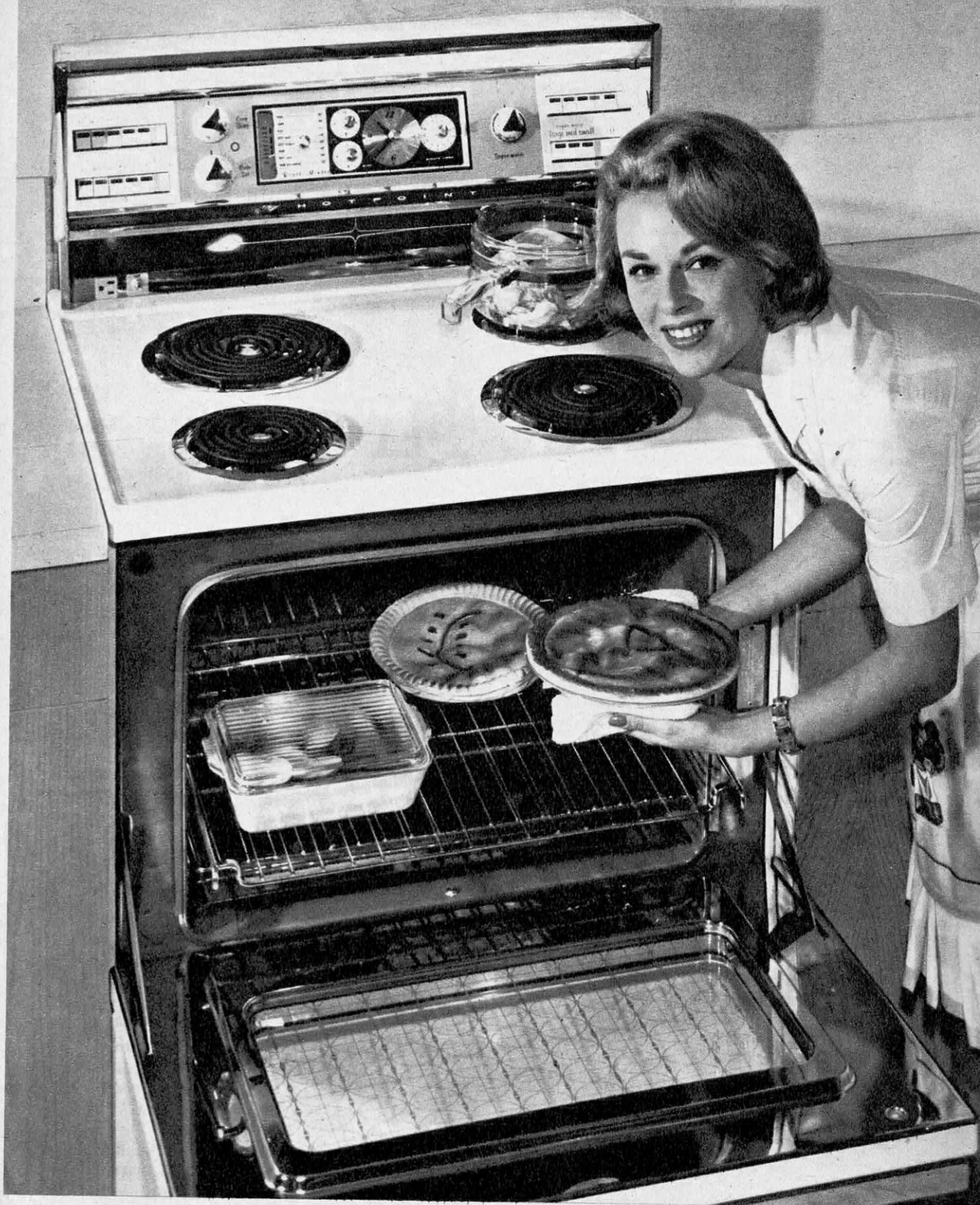
Une cuisinière électrique « à l'américaine » avec quatre foyers de cuisson à cinq allures, four à thermostat, broche, porte à hublot détachable pour le nettoyage, gril rabattable, commande par boutons poussoirs lumineux, minuterie d'allumage et d'arrêt automatiques.
