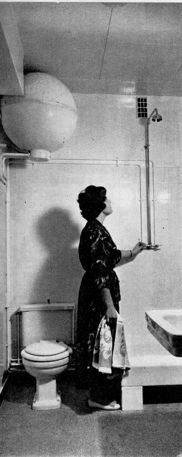
Dans une salle de bains un peu exiguë, un chauffe-eau sphérique à accumulation ici de 75 litres, 900 watts, se loge sans encombrer. Sa forme assure, à volume donné, un minimum de pertes de chaleur par la surface extérieure.
