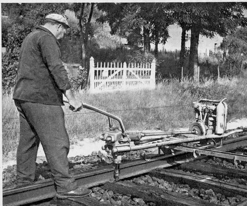
La mécanisation allège la tâche des équipes : ici une tirefonneuse.
