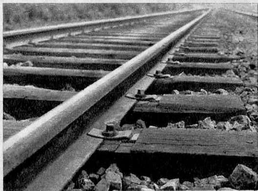
Voie principale à rails soudés sur traverses en bois avec fixations élastiques et pose sans selle.
