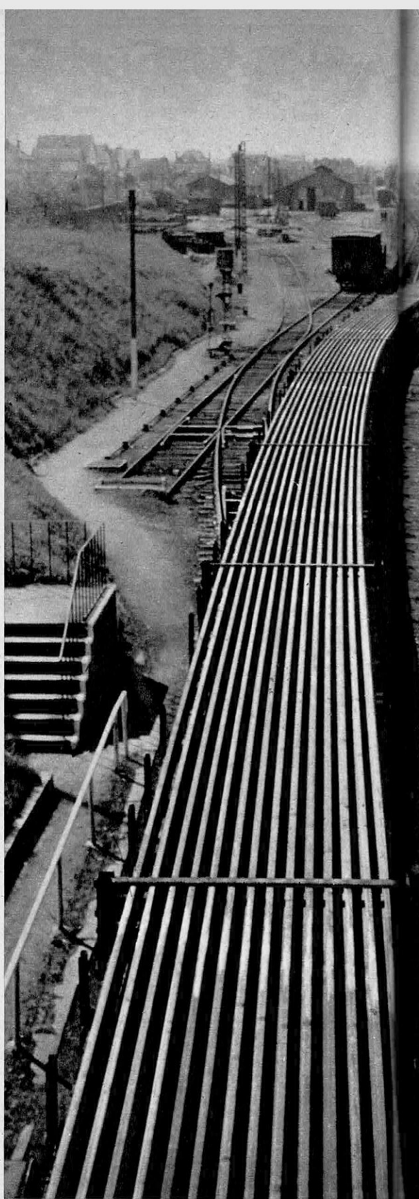
La surprenante souplesse des rails de 300 m
