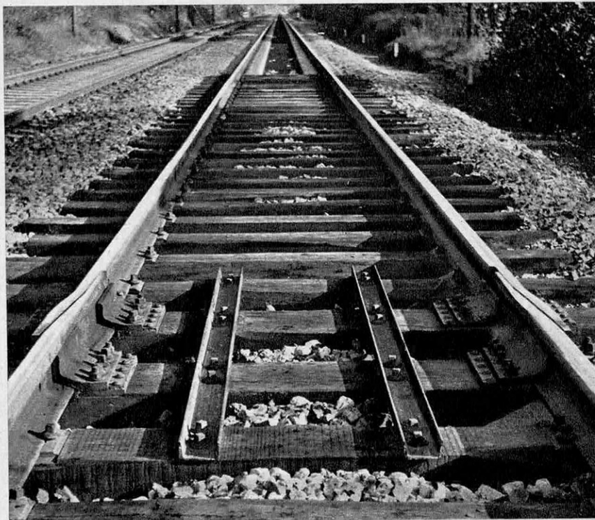
Joint spécial sur une ligne équipée en barres longues.
