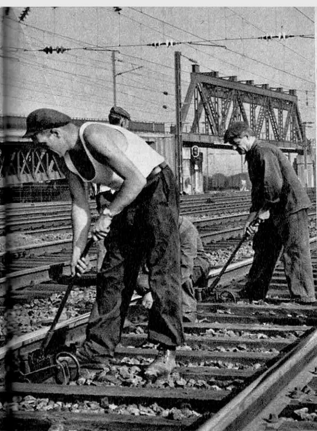
← A gauche, le dressage des voies tel qu'il était effectué « à la pince » ; avec le cric hydraulique, quatre hommes suffisent pour « riper » la voie.
