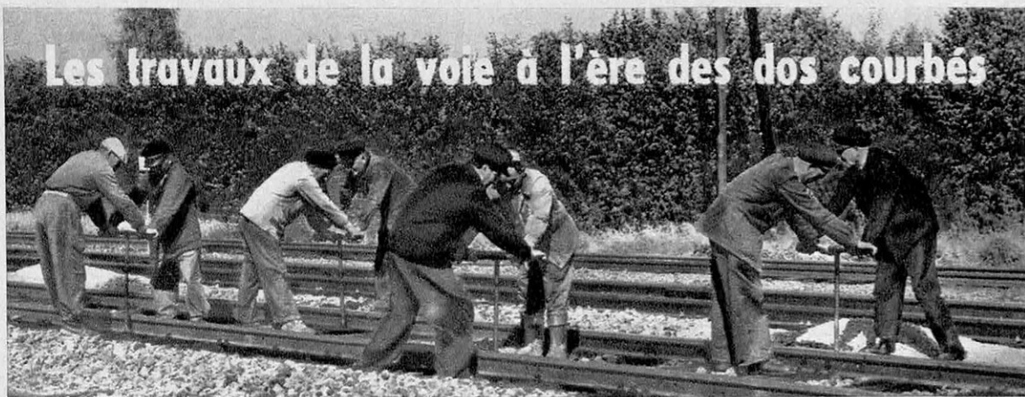
Le serrage des attaches à la clé à tirefonds.
