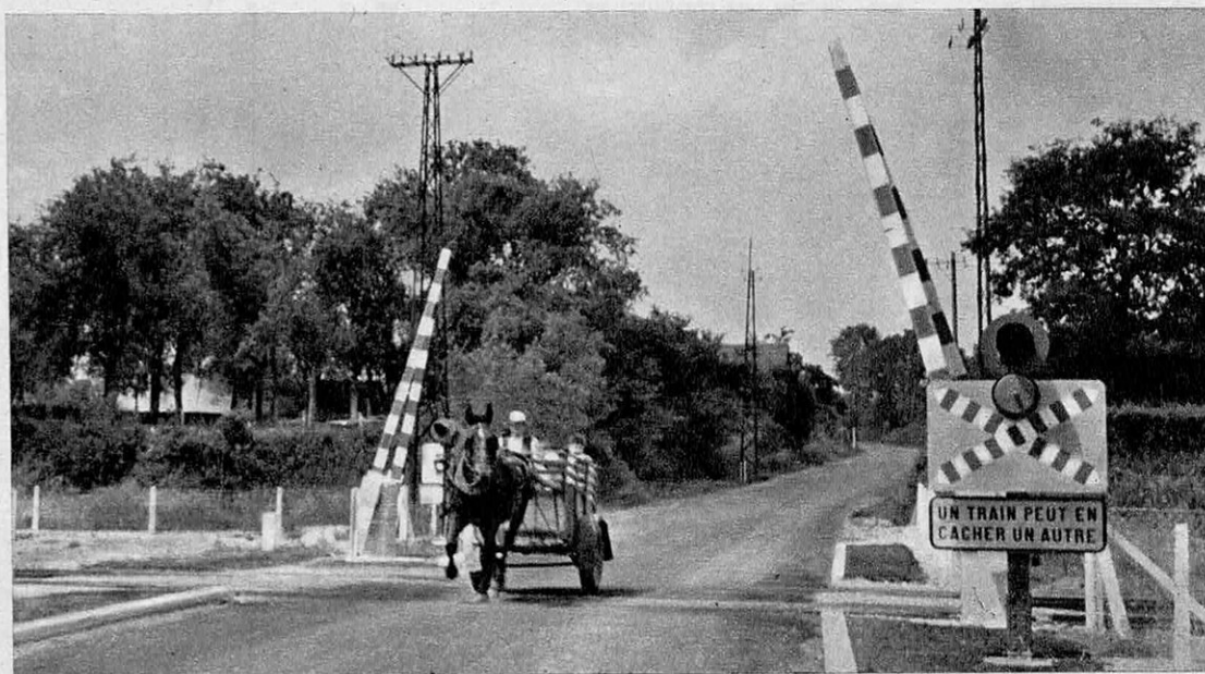
Les dispositifs de signalisation et de fermeture sont déclenchés par les trains.
