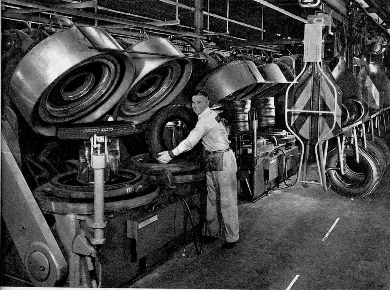
Chez Firestone. Un même convoyeur (à droite) apporte les carcasses brutes et remporte les pneus vulcanisés (à gauche).
