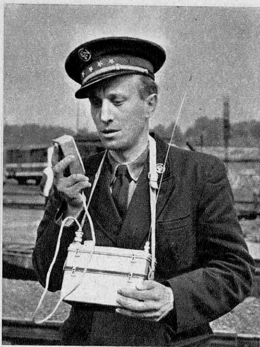
POUR LES MANŒUVRES , ce poste portatif de radiotéléphonie à courte distance, adopté par la S.N.C.F., remplace avantageusement les signaux à bras classiques parfois peu visibles.
