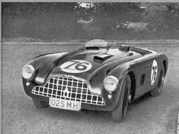
1952 Engagée au Grand Prix de Monaco, la DB 3 avec moteur 3 litres, dut abandonner sur rupture de bielle. Elle ne fut pas plus heureuse aux 24 H avec un moteur 2,5 l.
