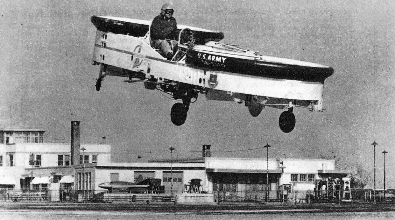
LE PIASECKI VZ 8P a volé pour la première fois le 12 octobre 1958. Beaucoup moins vulnérable qu'un hélicoptère grâce à ses hélices carénées et sa faible hauteur, il peut virer sur place et se déplacer dans tous les sens.
