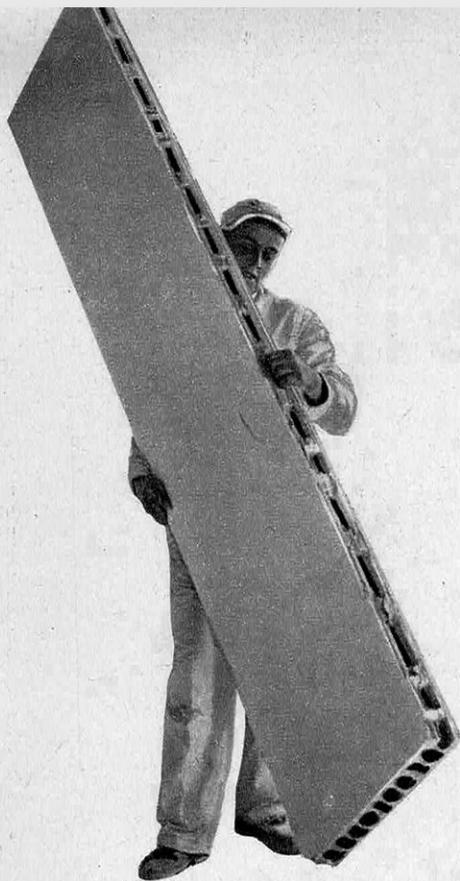
*La pose des cloisons TH, extrêmement simple, peut être réalisée par de la main-d'œuvre non spécialisée.*
