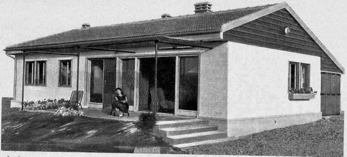
« La Louisiane », dernière création Phénix, est un pavillon de quatre pièces de grand confort. Les murs à doubles parois, béton et bois reconstitué, sont montés sur ossature métallique, les divers éléments étant préfabriqués en usine.
