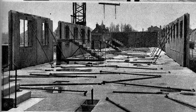
*Les éléments de chauffage sont en général incorporés aux planchers qui sont coulés sur place. Ci-dessus, pose d'un ensemble de tuyaux de chauffage et de distribution de gaz et d'électricité ; ci-contre, les jambes de force ont été disposées avant l'arrivée des divers éléments de l'étage suivant.*
