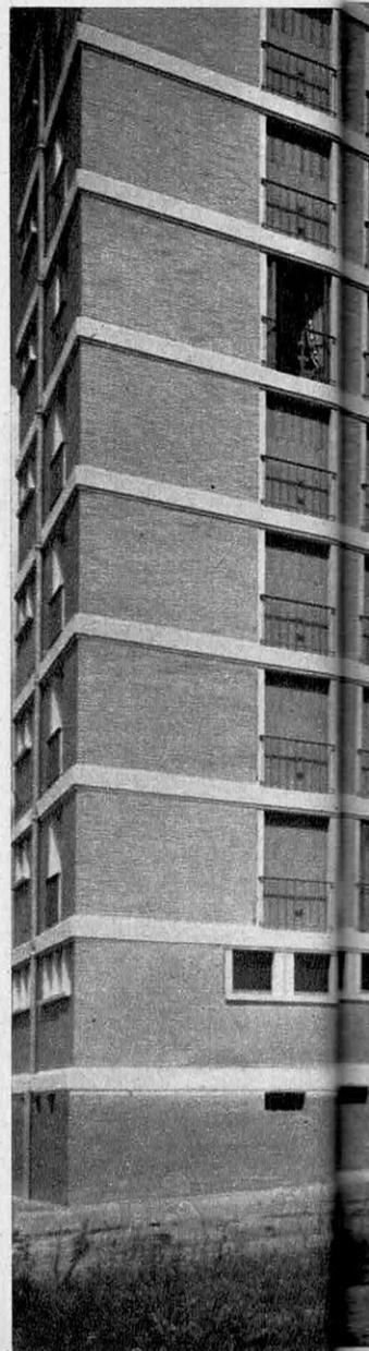
flateur à l'œil, bons isolants thermiques et phoniques, opposant une barrière efficace à l'humidité et d'un montage rapide. La combinaison de différents blocs permettent d'obtenir toutes les épaisseurs désirées.
