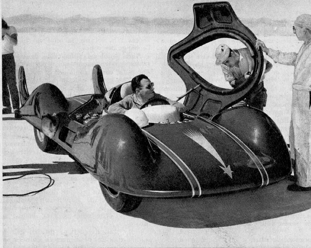
309 km/h Premier record de vitesse homologué pour une voiture à turbine: l'« Étoile Filante » de la Régie Renault. Assimilable à un fuselage d'avion avec une structure tubulaire en acier, la carrosserie de cet engin renferme une turbine Turboméca qui développe 270 ch à 28 000 t/mn. Un réducteur à 3 étages transmet la puissance aux roues arrière. Les dimensions sont réduites: empattement 2,40 m, longueur 4,84 m.
