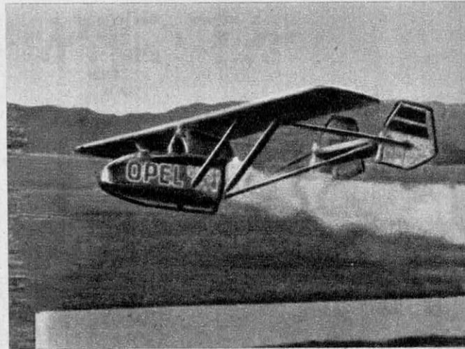
Le premier planeur à réaction piloté par Opel. Le 30 septembre 1929 il parcourut 1 500 m. La propulsion était assurée par six fusées à poudre.
