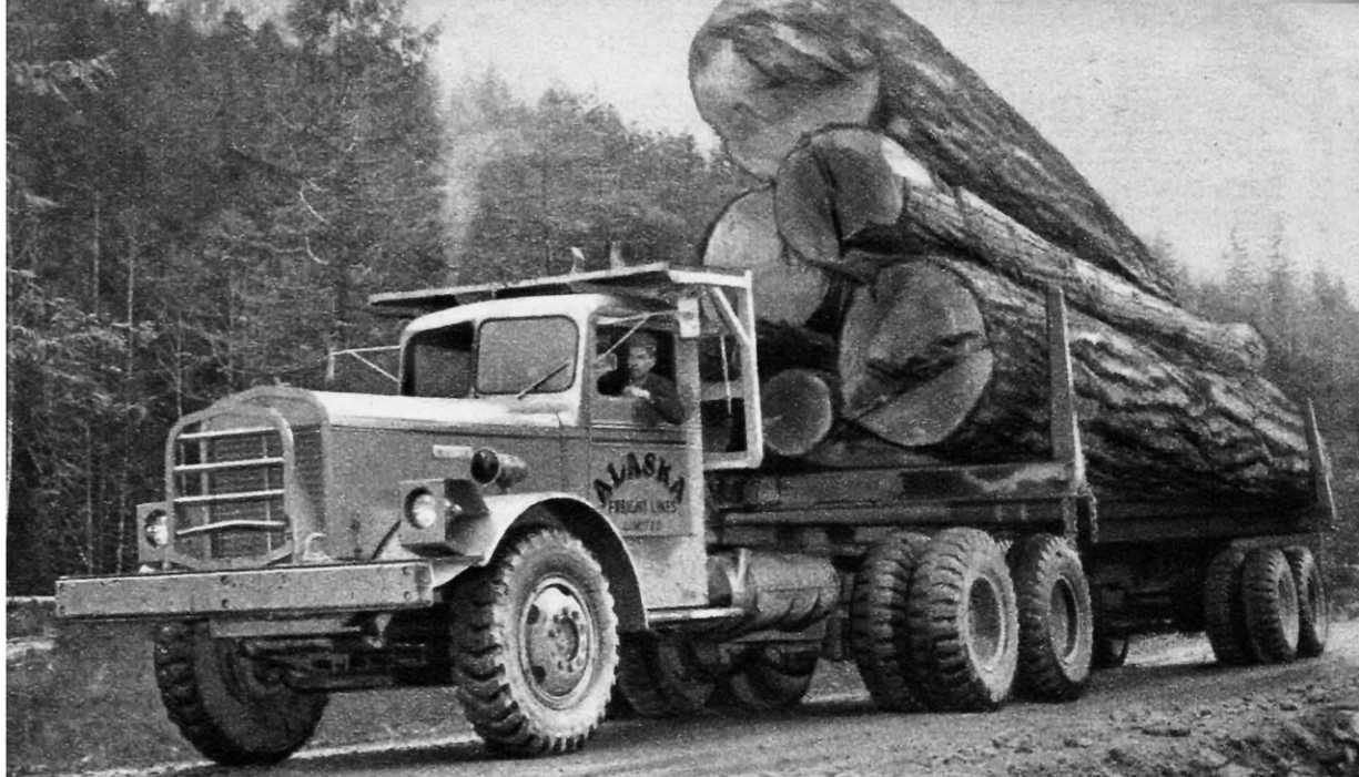
TRACTEUR KENWORTH, TYPE 588, MOT. DIESEL 150 CH, 2 ESSIEUX A RMOTEURS. CHARGE ROULANTE: 40 T.
