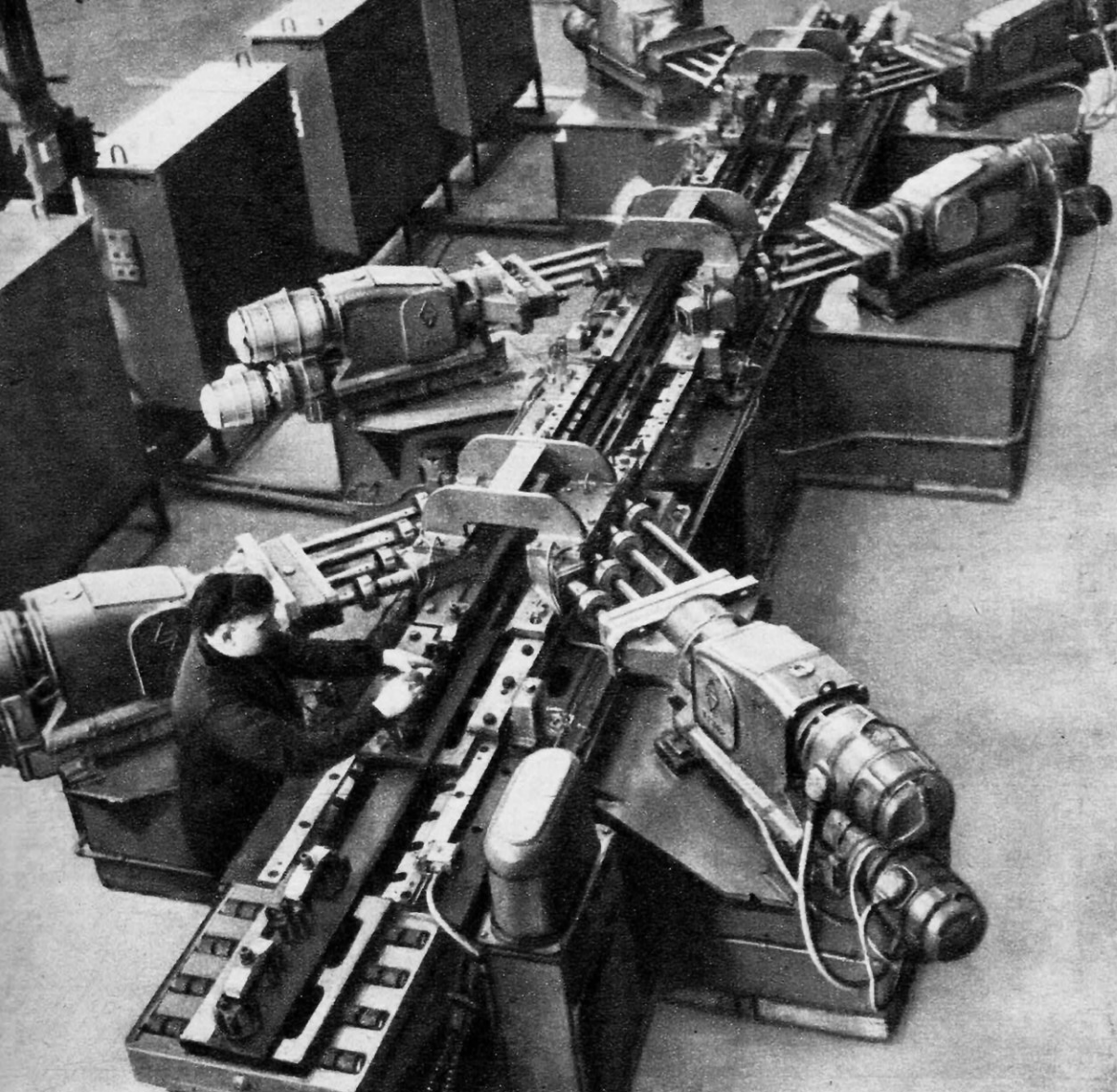
Dans cet atelier de la régie Renault, sont fabriqués les corps d'amortisseurs de la nouvelle voiture 4 chevaux. Ces machines effectuent simultanément le détourage et l'alésage des corps d'amortisseurs.
