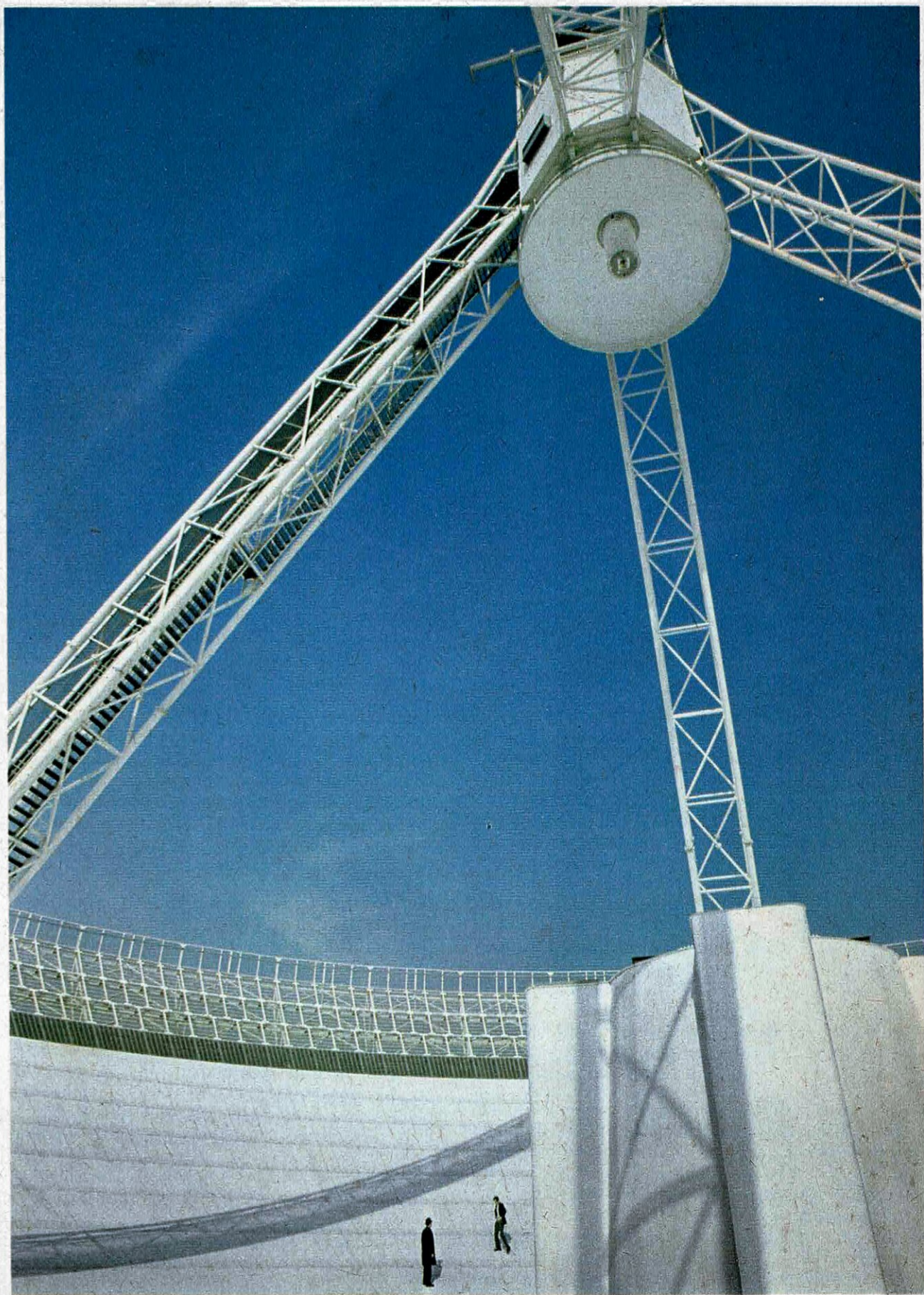
Au fond du bol immense — 100 m de diamètre — porté à 60 m au-dessus du sol par une structure géante, mais orientable en tous sens, les dimensions astronomiques prennent toute leur valeur ! Les ondes radio émises par les étoiles sont réfléchies par la soucoupe parabolique et viennent converger au foyer (en haut et à droite sur notre document).
