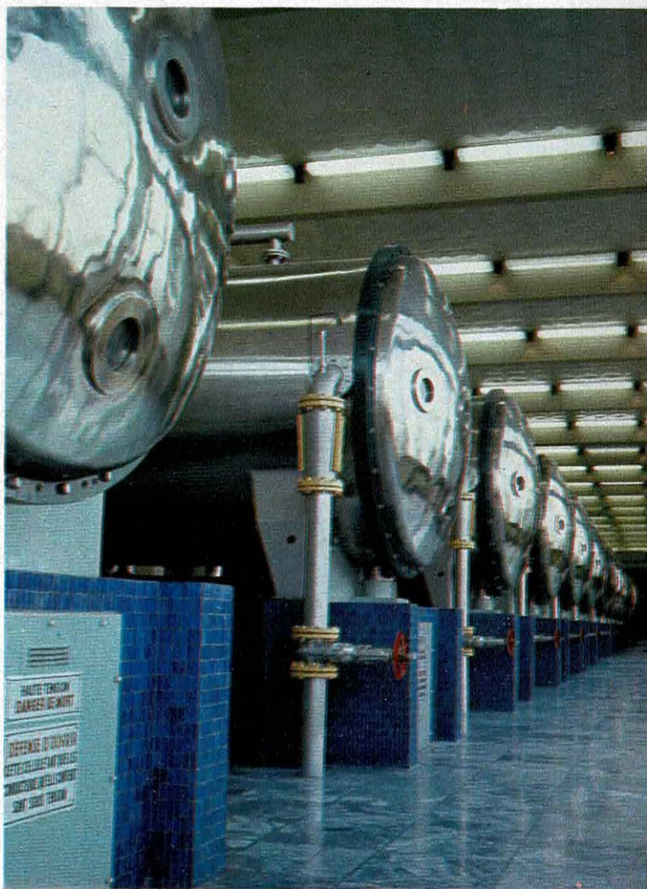
Les ozoneurs de l'usine E. Pépin de Choisy-le-Roi. Ce sont des ozoneurs de ce type qui ont été vendus par « Trailigaz », la filiale de la C.G.E. à Manchester, Moscou, Kiev et Bruxelles.
