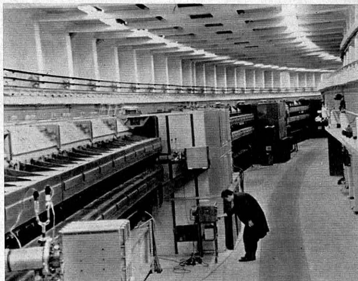
Une idée de la complexité des appareils relatifs à un double anneau de stockage et d'intersection. Le double arc d'électro-aimants représente 250 mètres.
