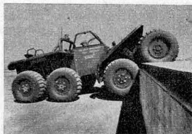
Le « Twister » escaladant un mur d'un mètre de hauteur.
