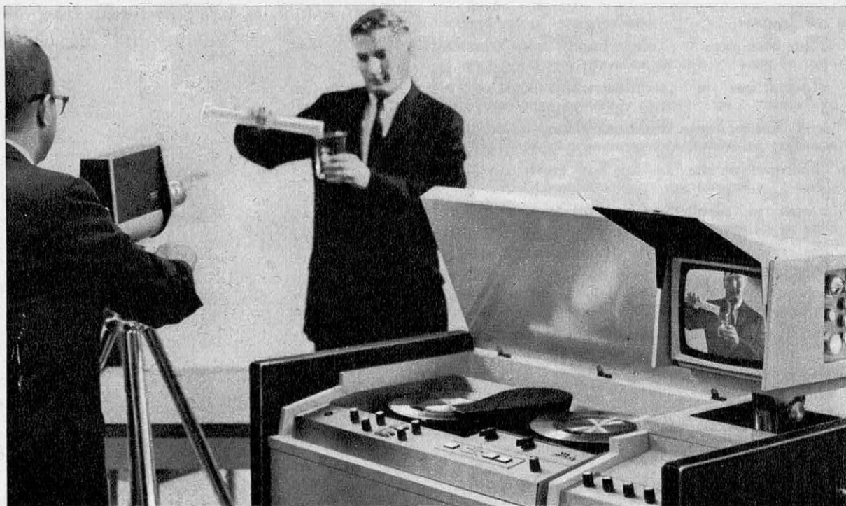
Des signaux video enregistrés à 180 km/heure, immédiatement reproductibles... (Ampex VR 7003).
