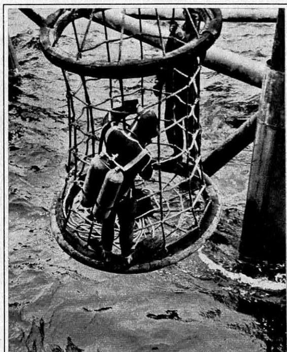
Outre les « pieds lourds » (les scaphandriers) la prospection sous-marine utilise des hommes-grenouilles. Leur travail consiste à surveiller le forage, démêler les câbles-guides embrouillés, etc. Ils ne travaillent, bien entendu, qu'en « eau chaude » : au large des côtes de Californie, du Mexique et du Vénézuéla, aux Bahamas et en mer Rouge.
