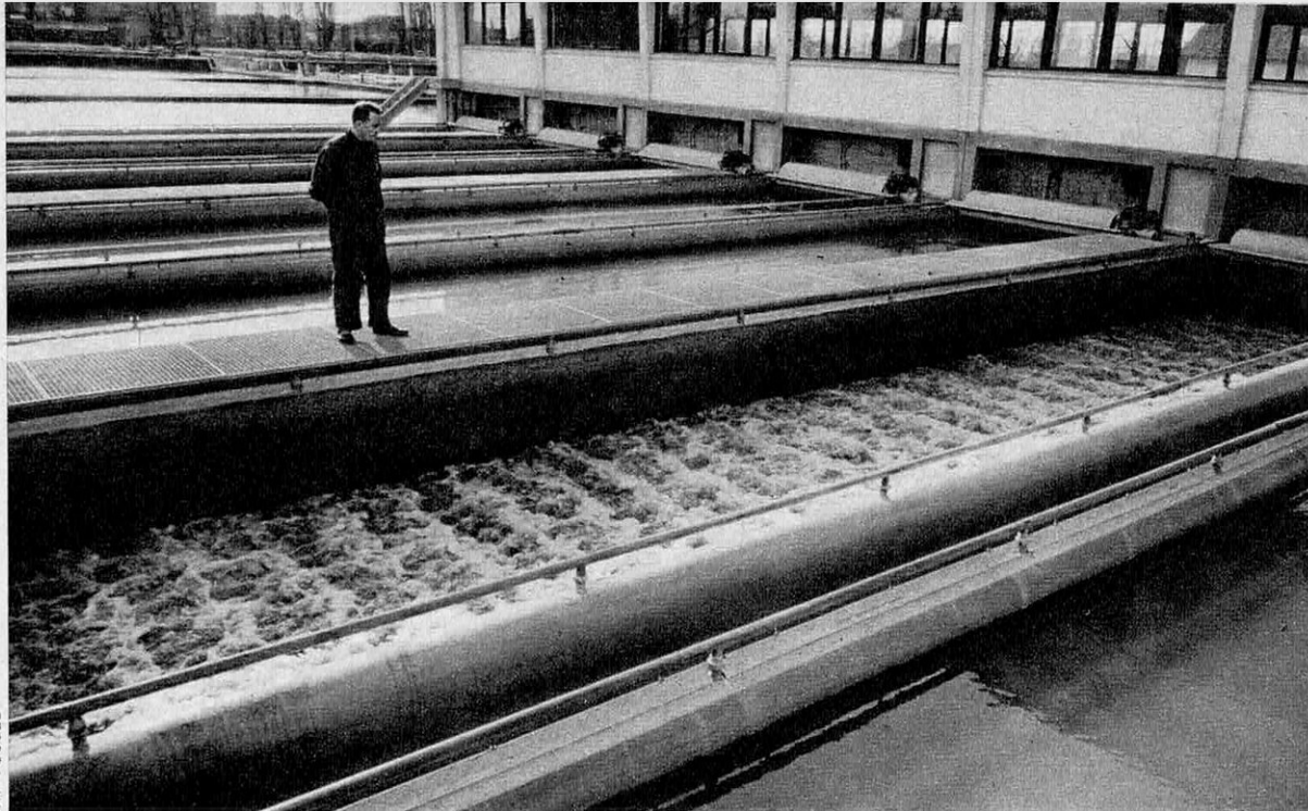
Trois filtrages, dont deux dans des sables de plus en plus fins, précèdent le traitement chimique de l'eau destinée aux villes.
