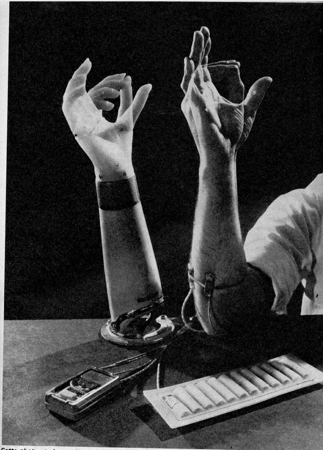
Cette photo stroboscopique montre comment la main artificielle reproduit fidèlement les mouvements de préhension de la main vivante.
