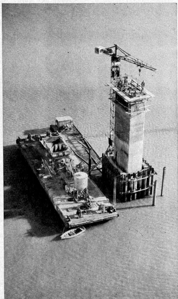
Tous les piliers de béton prennent appui sur le rocher qui tapisse le fond de la mer.
