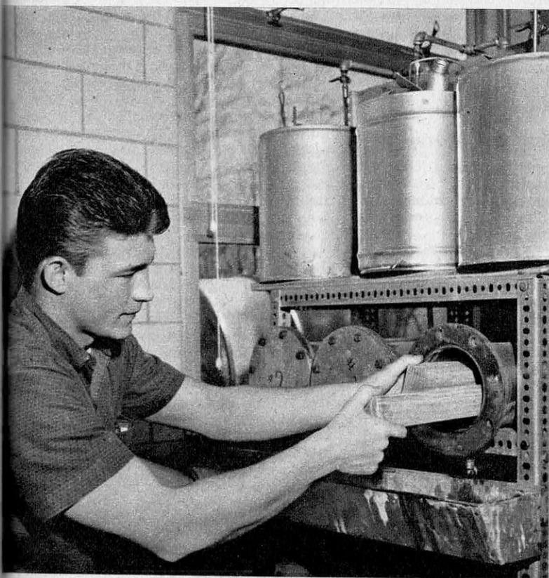
A la West Virginia University, un étudiant enfourne des échantillons de bois dans le tube où ils seront imprégnés de monomère sous pression, avant l'irradiation.
