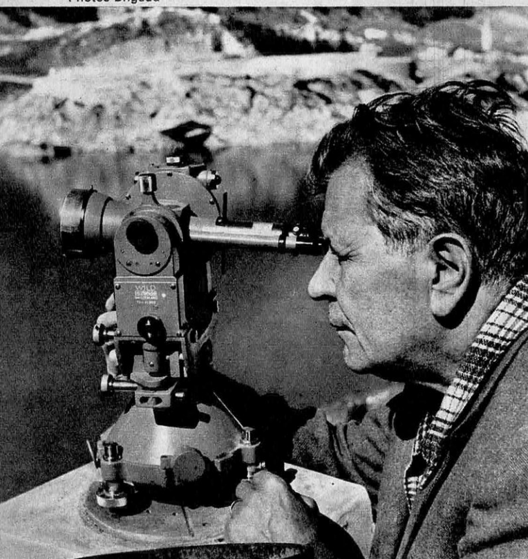
D'un repère fixe, visée sur la crête du barrage.
