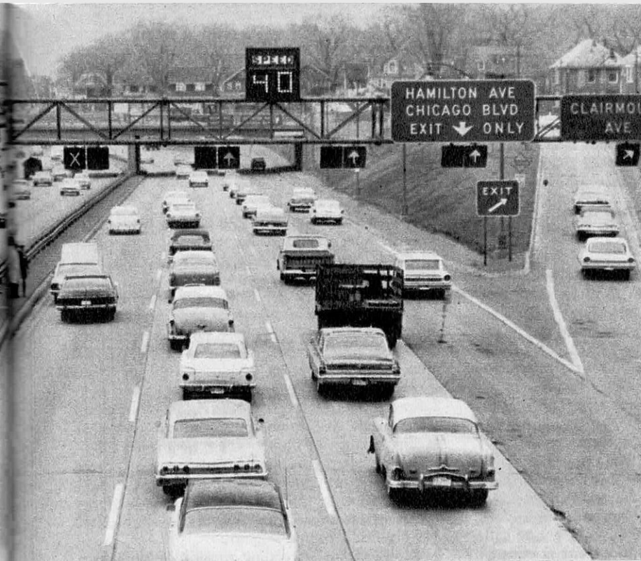
Grâce aux informations reçues, des instructions sont directement communiquées, par panneaux lumineux, aux automobilistes : ici, à la suite d'une panne survenue sur la voie de gauche, la vitesse est limitée à 40 miles.
