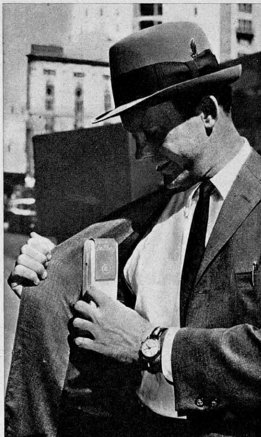
Ci-dessus : Un exemple de réalisation américaine. Le récepteur d'appel « Bellboy » équipé au gré de l'utilisateur de micro-batteries au mercure (d'une durée de 100 heures) ou d'accumulateurs rechargeables.
