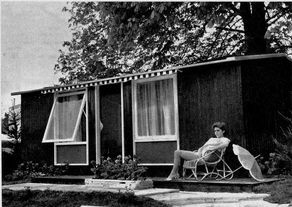
Ce n'est déjà plus du camping: le bungalow a remplacé la tente. Cette habitation est réalisée au moyen d'éléments standard préfabriqués (ou « modules ») assemblés à la dimension désirée. Toutes les combinaisons
