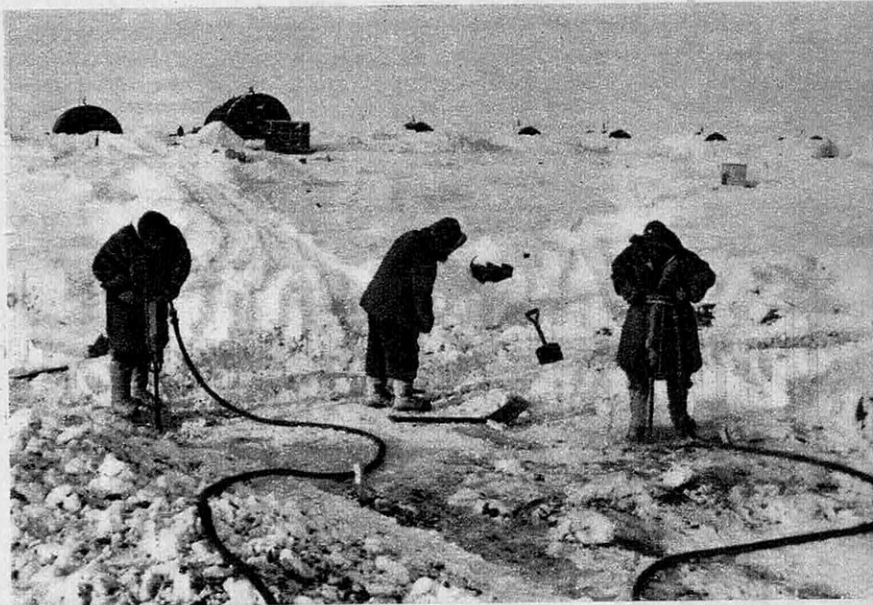
Il faut des marteaux-piqueurs pour aménager ce site de la Terre de Baffin, où tout le matériel a dû être amené par avion.
