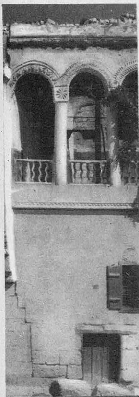
à la paroi verticale d'un maisons en tuf taillé se pré- aux moindres aspérités.
