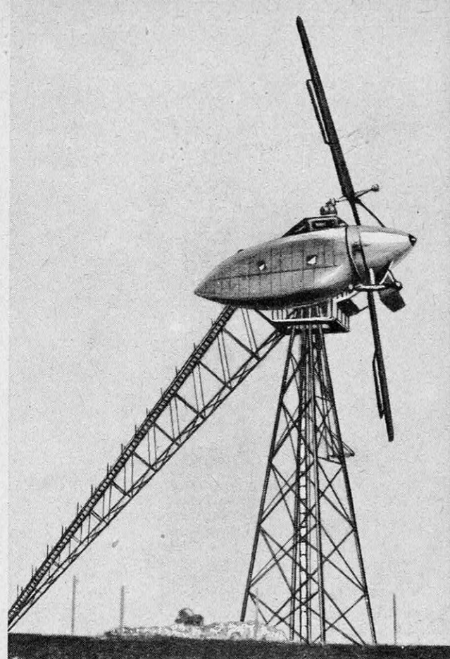
La machine aérienne russe de Yalta, achevée en 1931, avec 31 m de diamètre et 100 kW de puissance, fonctionna jusqu'à sa destruction en 1941. Sa moyenne de production annuelle atteignait 279 000 kWh.
