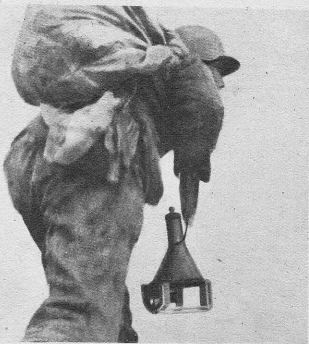
FIG. 7. — ATTAQUE D'UN CHAR AVEC DES CHARGES CREUSES A ADHÉRENCE MAGNÉTIQUE
