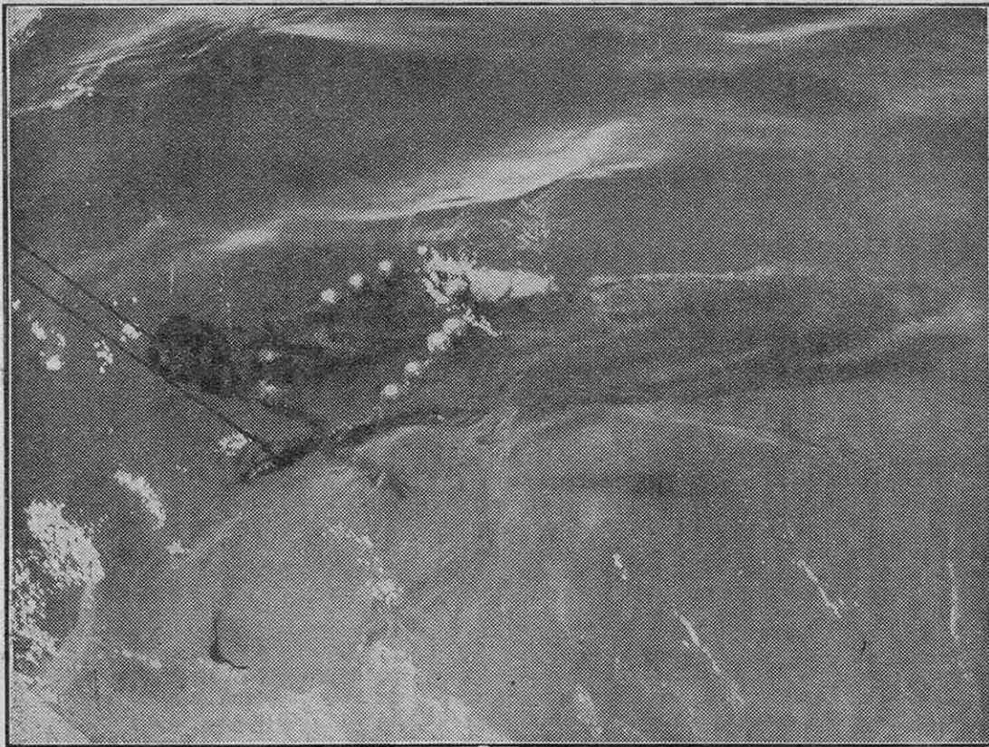
FIG. 6. — FILET A PLANCTON MIS A LA TRAINÉ ET MAINTENU OUVERT PAR DES FLOTTEURS EN VERRE.
