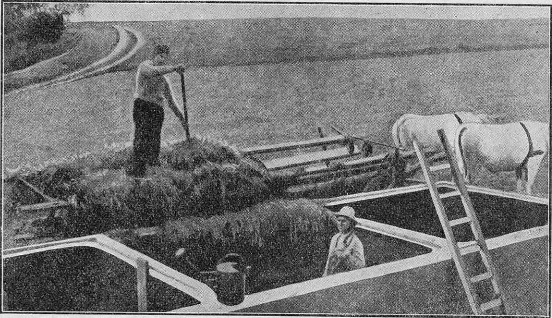
FIG. 9. — STOCKAGE ET SALAGE DU FOURRAGE DANS UN SILO FOSSE CONSTRUIT AU-DESSUS DU SOL
